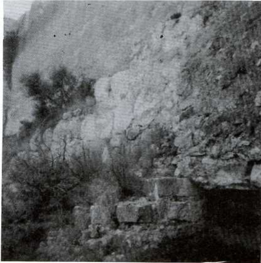
Fotografía 1.- Un fragmento de la muralla con nueve fustes, siendo el tercero empezando por la izquierda, el basamento de uno de ellos. Abajo a la derecha, puede apreciarse el posible basamento del edificio con los restos de la escalera.
