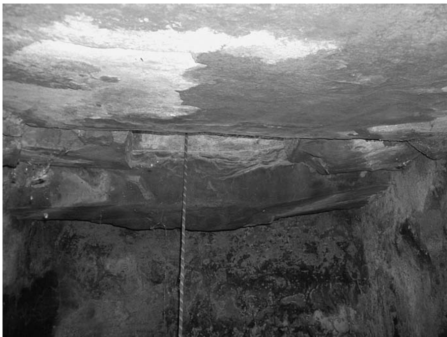
Cisterna ibera del Lllaner situada a la plaça d'Estudiants. Cal apreciar el sostre de lloses.
