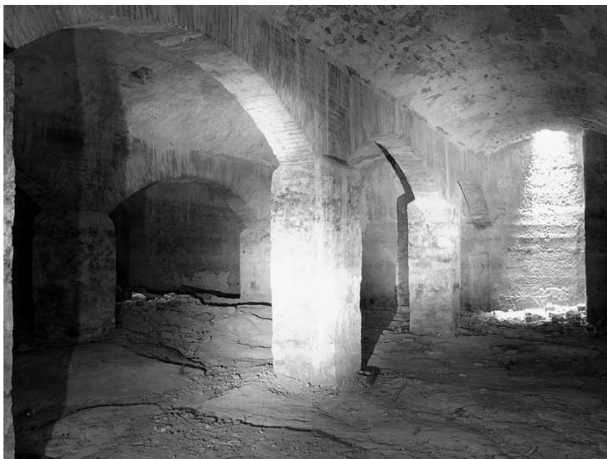
Cisterna dels Nou Pilars. Apreciem l'estructura de rajola.
