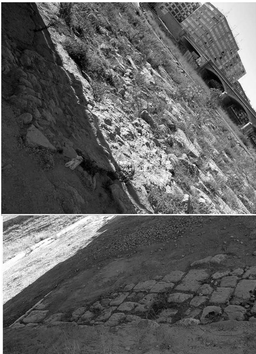
Lámina IX: Machón de puente arrasado y losas bajo el actual puente del ferrocarril.
