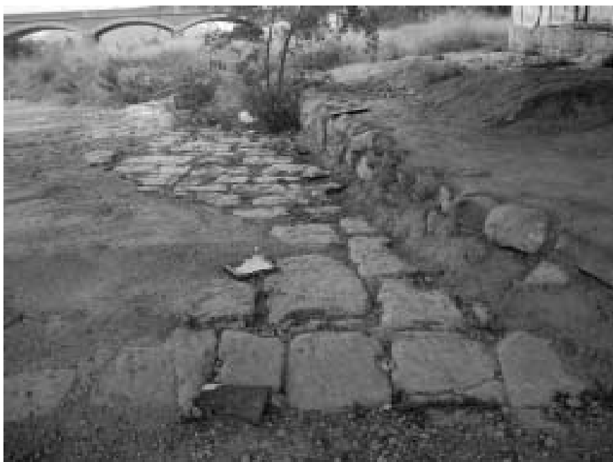
Losas bajo puente de hierro.
