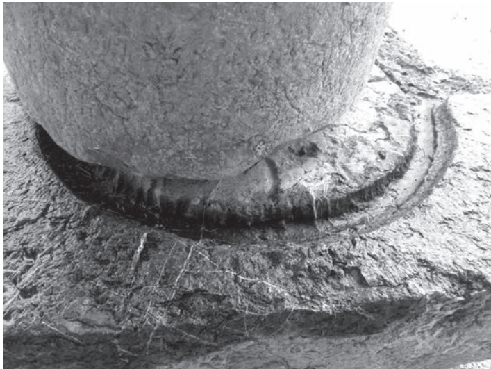
Fig. 5. Detall de les esquerdes sobre la roca.
