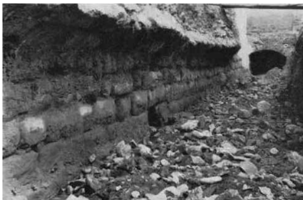
Fig. 11. Imagen del acueducto que discurre paralelo a la fachada del circo. Fuente: Bru, 1961.
