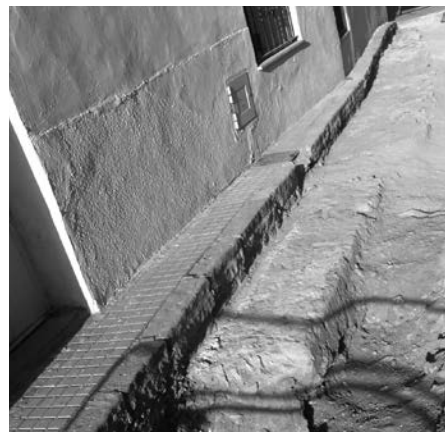
Tramo B de nº 18 a nº 16 (final).
