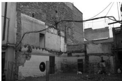
Foto: Restos en la medianera del solar.
