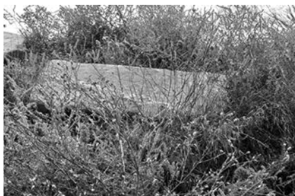
Sillar de piedra azul en talud de tren. Foto Ramón Ramón
