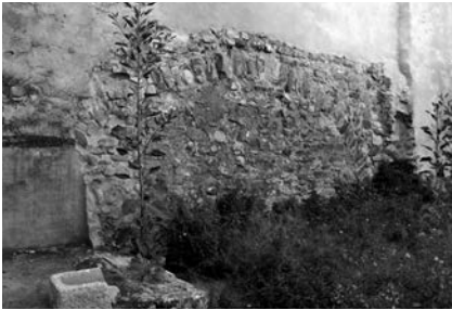
Foto: Restos en pared medianera. Gabinete de Comunicación.
