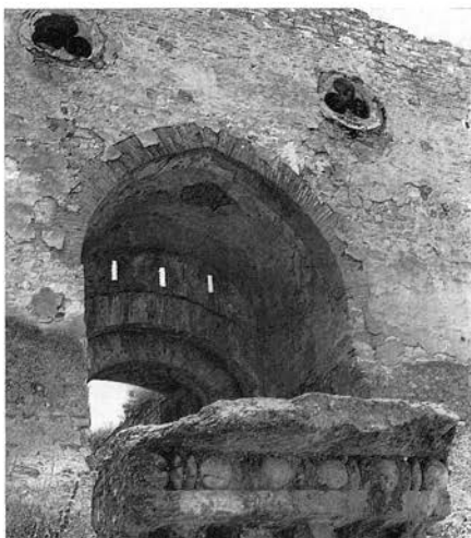
▲ En la puerta de Almenara, acceso a la plaza del mismo nombre, se conjugan diferentes épocas y estilos. Arriba, ladrillos y aberturas de construcción medieval, y abajo, los restos pétreos de una cornisa de la plena romanización. ◀
