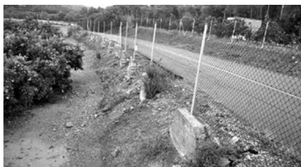
Estado inicial del camino. Foto: Ayto Sagunto.
