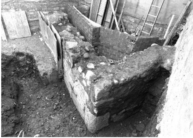
Vista lateral de la esquina del muro.
