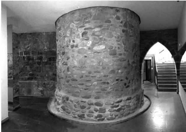
Torre conservada en zaguán en C/ Camí Real n° 50.
