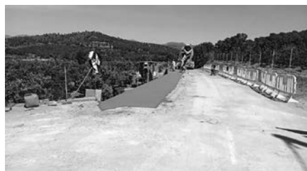
Reposición de firme. Foto: Ayto Sagunto.
