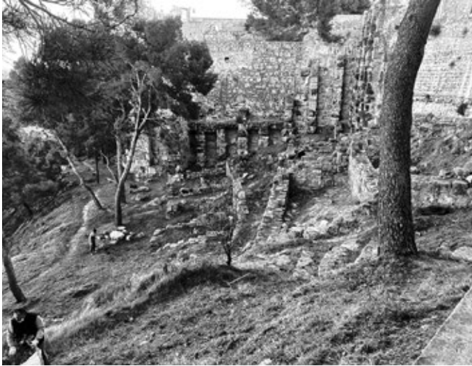
Imagen de donde se encuentran el segundo y tercer estadio previa a la intervención.
