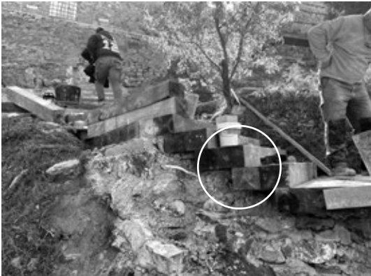
Imagen donde se muestra el solape de las traviesas para su trabado entre ellas y con la solera de regularización donde apoyan.
