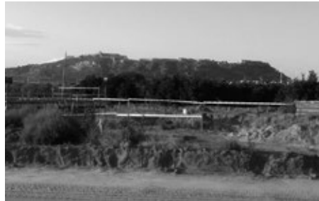
Castillo de Sagunto desde las obras.
