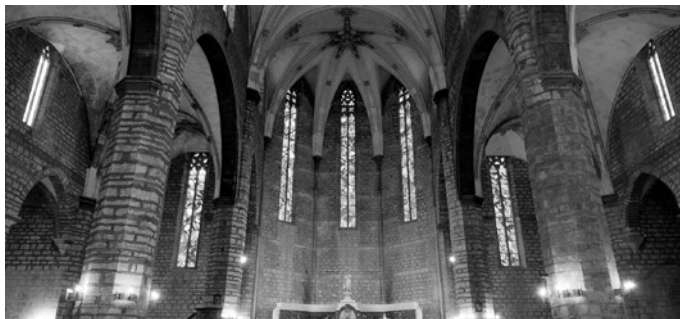
Ábside y ventanales desde el interior del templo.
