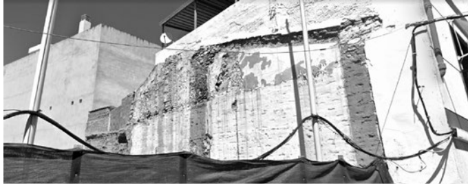
Tramo de muralla en la C/ Calvari en la medianera de los nº 27 y 29.
