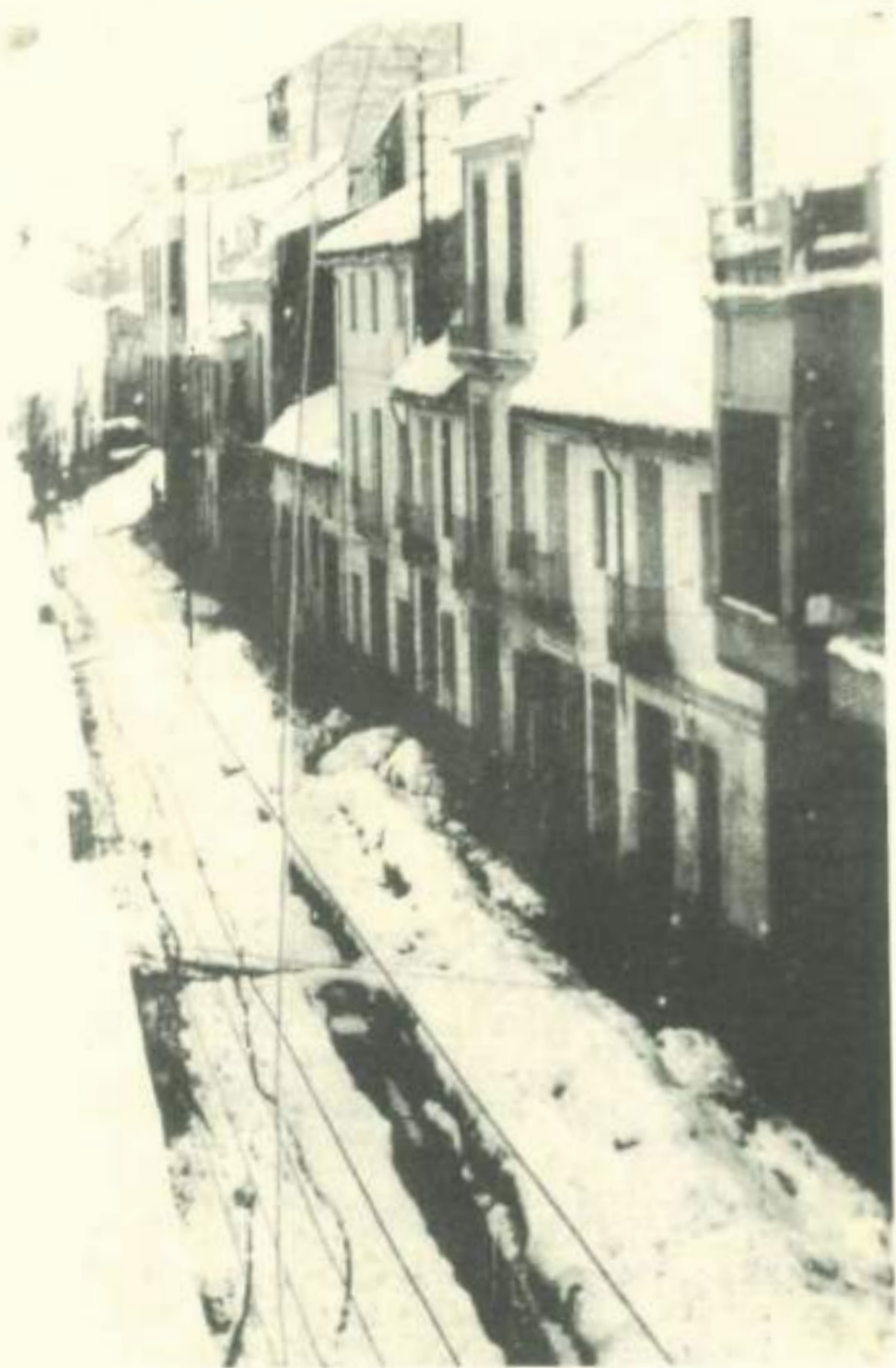
El Camí Real nevado, era el año 1946; el suelo se levantó y fue instalado el alcantarillado general.
